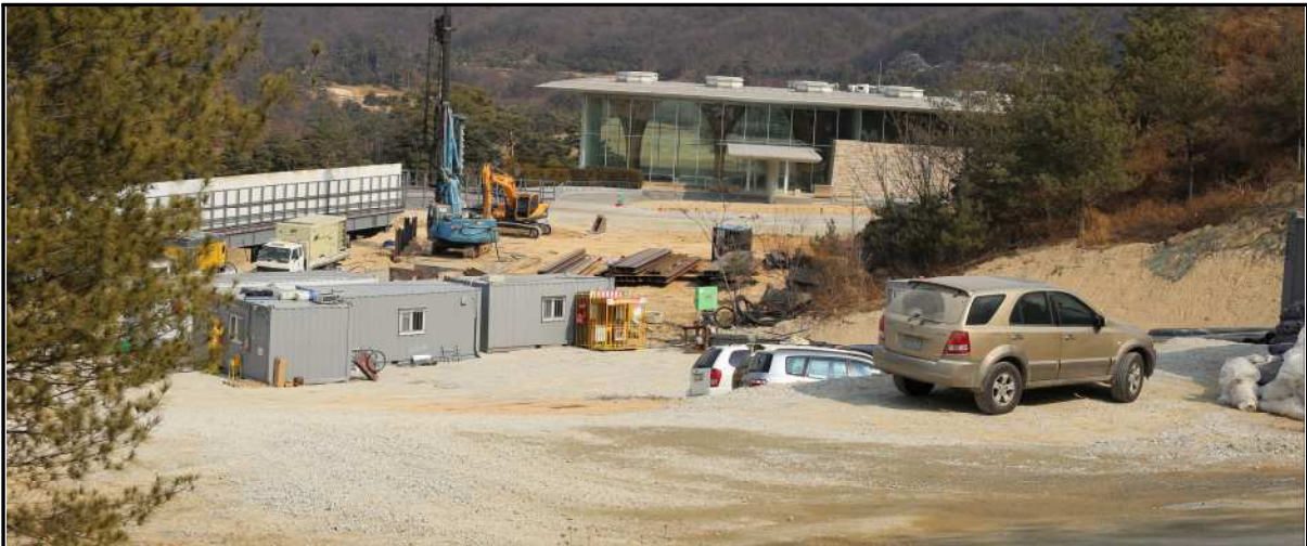
사업지구 내부 전경 ① (나인브릿지 골프빌리지(공사중))
